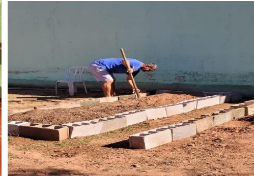
Construção da horta
