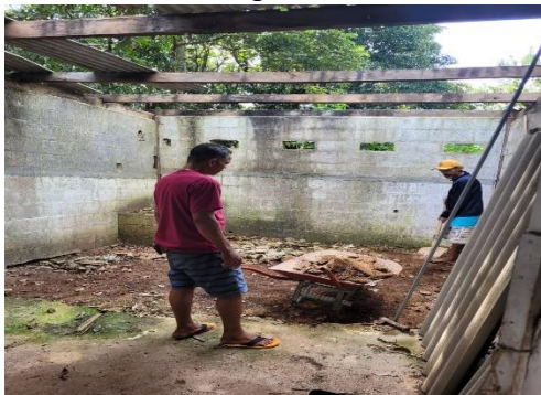
Processo de construção do galinheiro
