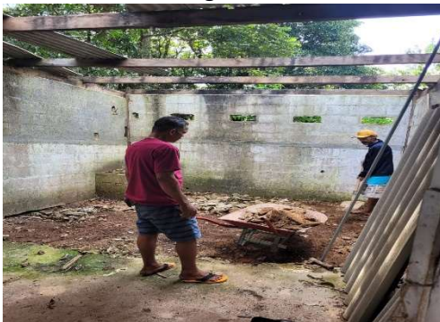
Processo de construção do galinheiro
