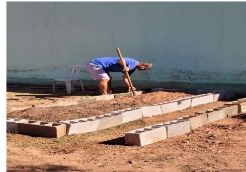
Construção da horta
